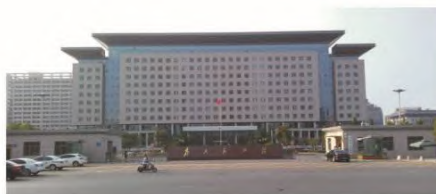
河南省政府综合办公楼
